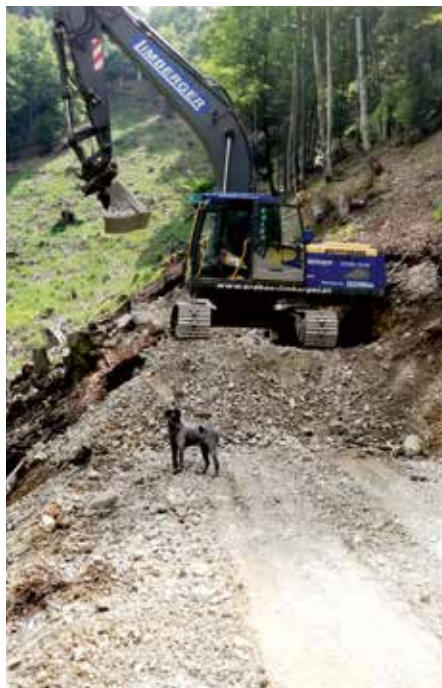
Forststraßen- und Rückewegebau sind Grundvoraussetzungen für waldbauliche Maßnahmen.
